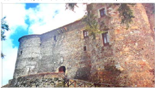
La parete Ovest del Castello normanno-svevo di Vibo Valentia
